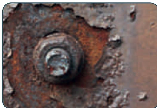
Figura 1 – Ferrugem resultante da oxidação do ferro exposto ao ar.
